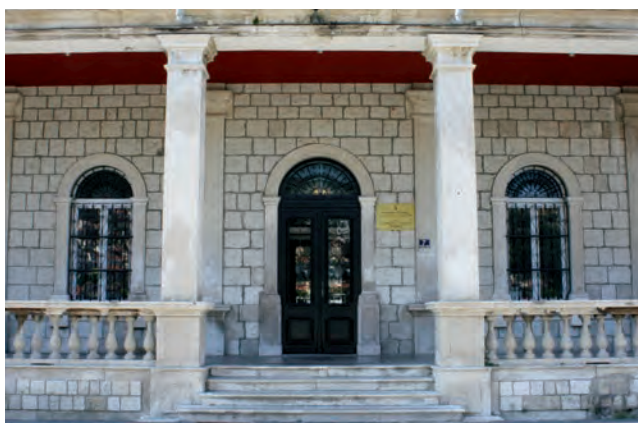
Glavni ulaz u zgradu Ville Elise
