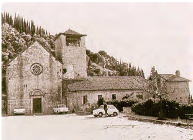
Zgrada Zavoda za istraživanje korozije i desalinaciju u Sv. Jakovu
