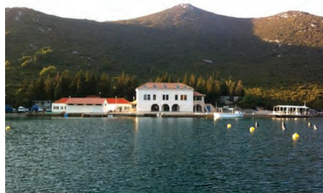
Zgrada MARIBIC-a na Bistrini
