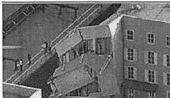
OD UDARA BRODA OŠTEĆENA JE I OBLIŽNJA ZGRADA
